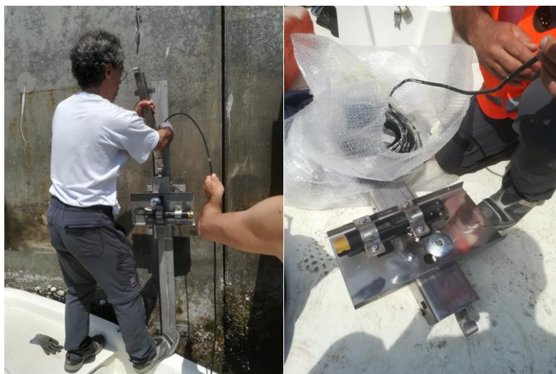
Figura 4. Installazione della stazione torbidimetrica alla bocca di porto di Malamocco.
